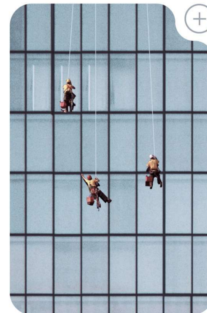
Работы на высоте
